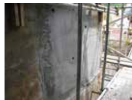
アバット補修の事例
