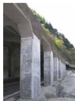
柱補修の事例
