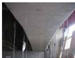
桁補修の事例
