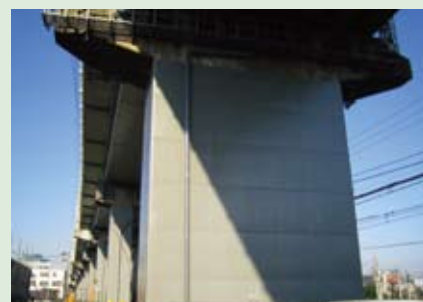
新幹線橋脚の耐震補強
