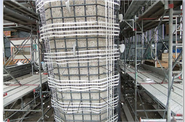
橋脚耐震補強増し厚ひび割れ補強
