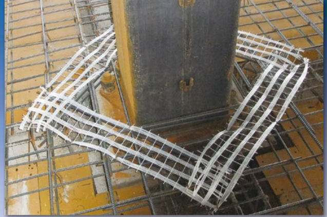
スラブ柱周りひび割れ補強
