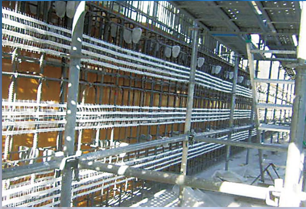
L型擁壁のひび割れ抑制
