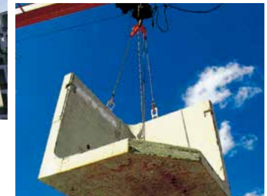
施工例3 (L型擁壁コーナー部)
