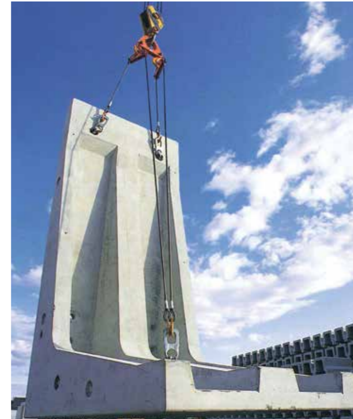
施工例1 (L型擁壁)
