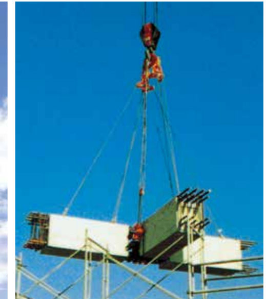
施工例2 (梁部材)
