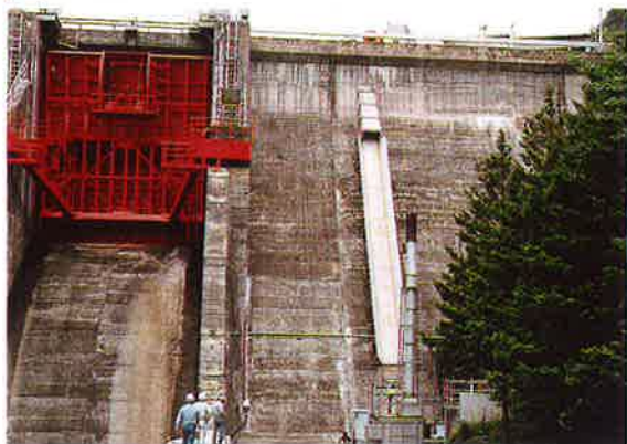
■ダム 【未処理面】
