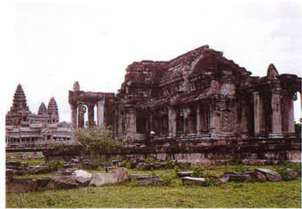
アンコールワット外周壁内北経蔵 藍藻類による異変現象が著しい (撮影：JSA新井英夫氏)
