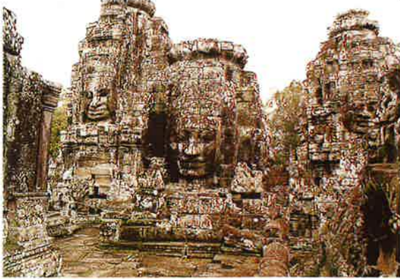
アンコールトムのバイヨン中央伽藍の仏面塔 仏面彫刻にも地衣類等の繁殖が著しい (撮影：JSA新井英夫氏)
