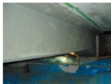
⑤接着材上塗工
