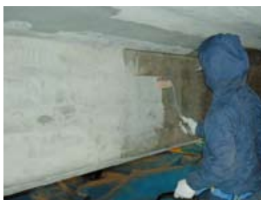
②プライマー工
