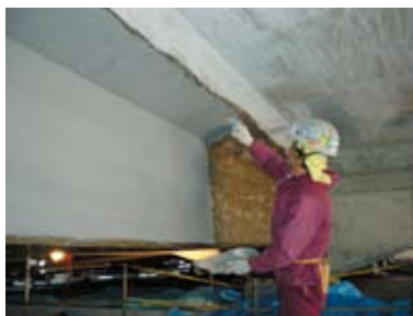
③不陸調整及び接着材下塗工
