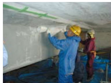
④連続繊維シート貼付工
